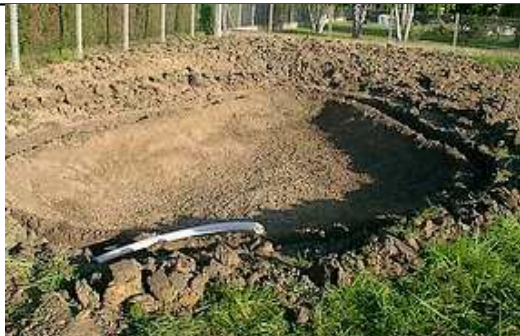
3- Tuyau de trop plein installé
