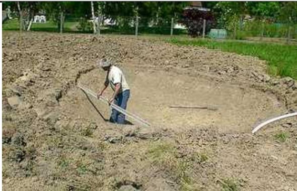
3- Tuyau de trop plein installé
